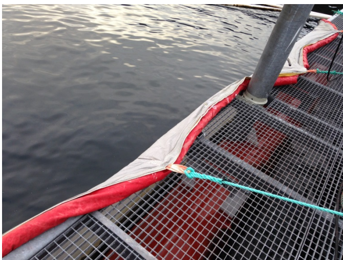
Figur 23. Skjørt montert på Saltkjelen der det har blitt dratt for høyt opp.
